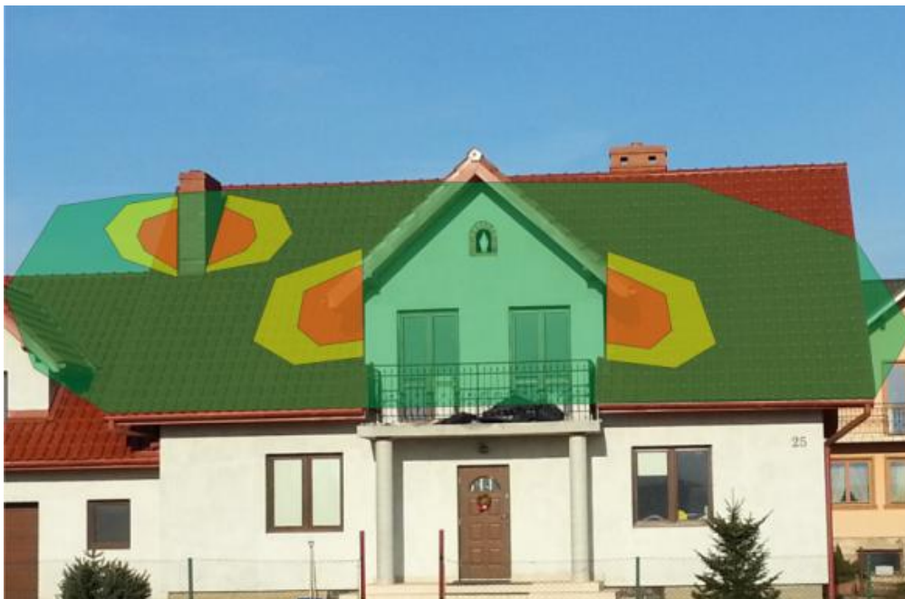
Rys. Strefy zacienione na dachu skierowanym na południe – w tych miejscach nie powinno się umieszczać modułów fotowoltaicznych.
